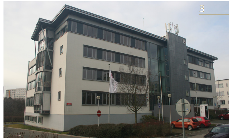
DAS GEBÄUDE IN DER PEKAŘSKÁ STRASSE 16
