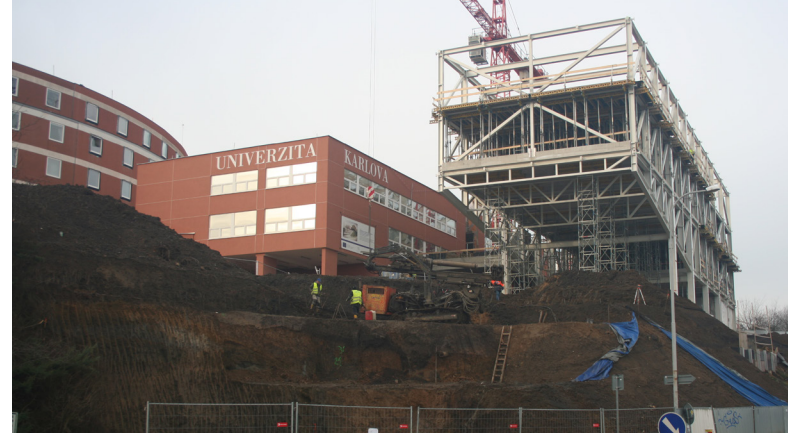
DIE BAUSTELLE IN DER U KRÍŽE STRASSE 8
