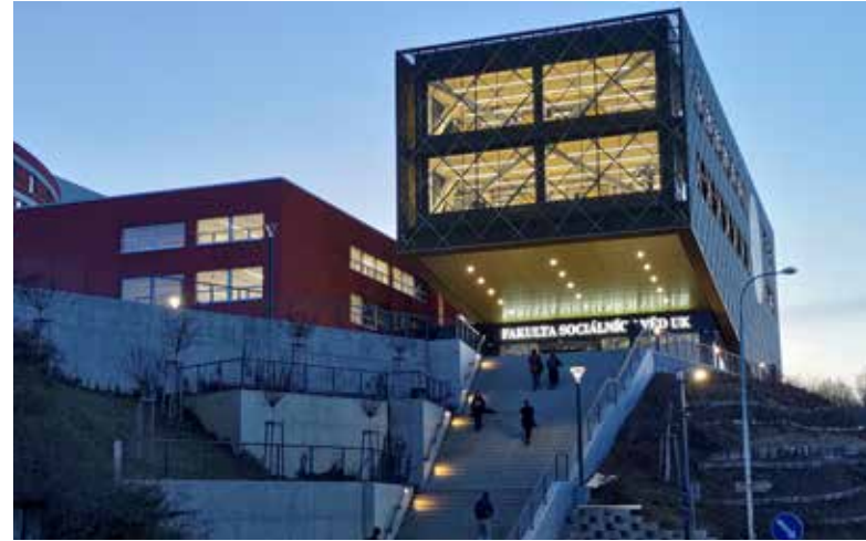
GEBÄUDE IN DER STRASSE U KRÍŽE NACH DEM UMBAU
